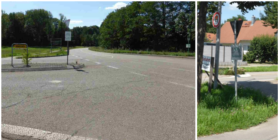
Abbildung 10: Ausgebleichte Beschilderung entlang der K5369; Fahrtrichtung nicht erkennbar (links), beschmutzte Beschilderung in Zusenhofen (rechts)
