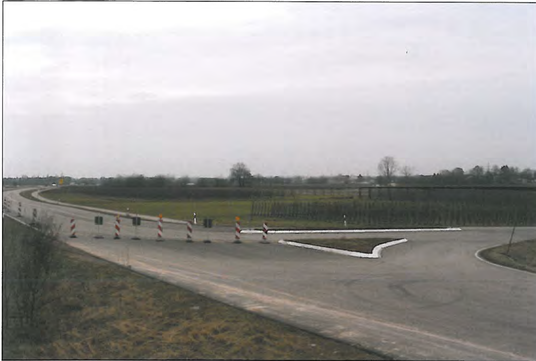
Bild 1 Kreuzungsbereich B 28 / Querspange West. Planungsgebiet im Hintergrund.
