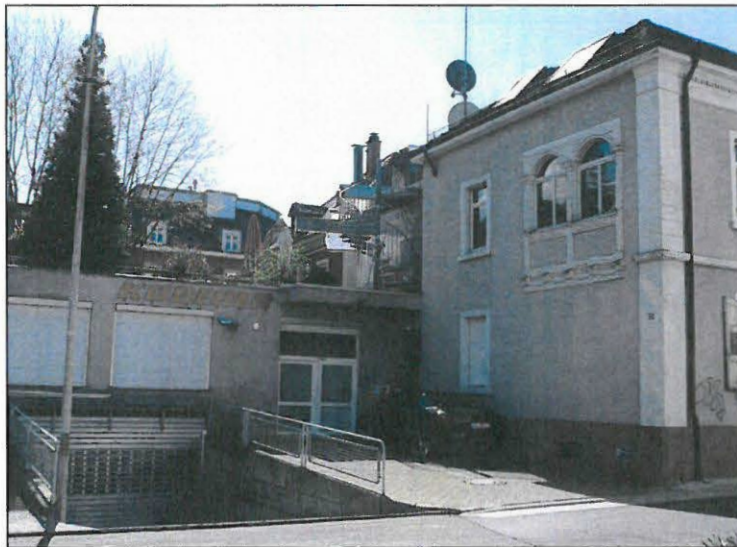
Foto: Gebäude Hauptstr. 79, Ansicht Kapuzinergasse, 2018
