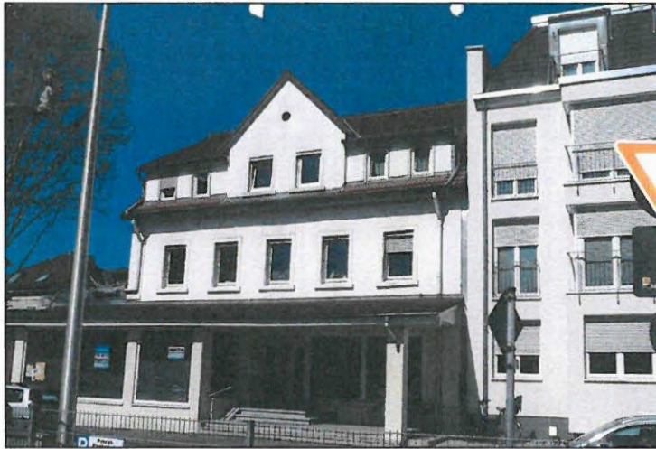
Foto: Gebäude Renchener Str. 2, Ansicht Renchener Straße, 2018
