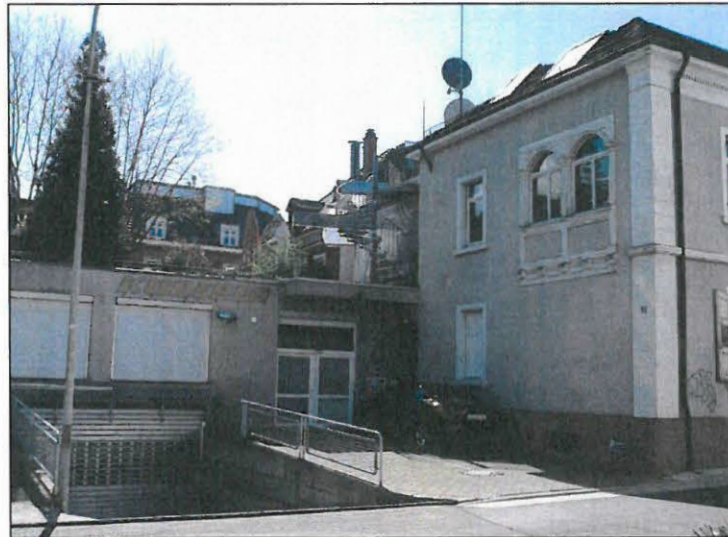
Foto: Gebäude Hauptstr. 79, Ansicht Kapuzinergasse, 2018
