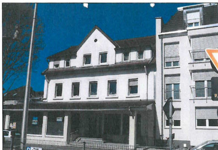
Foto: Gebäude Renchener Str. 2, Ansicht Renchener Straße, 2018
