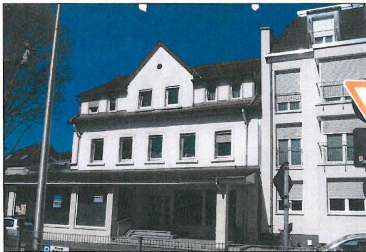
Foto: Gebäude Renchener Str. 2, Ansicht Renchener Straße, 2018
