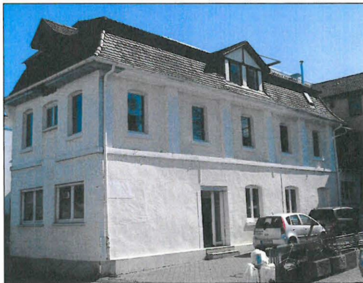
Foto: Gebäude Renchener Str. 2, Ansicht Kapuzinergasse, 2018
