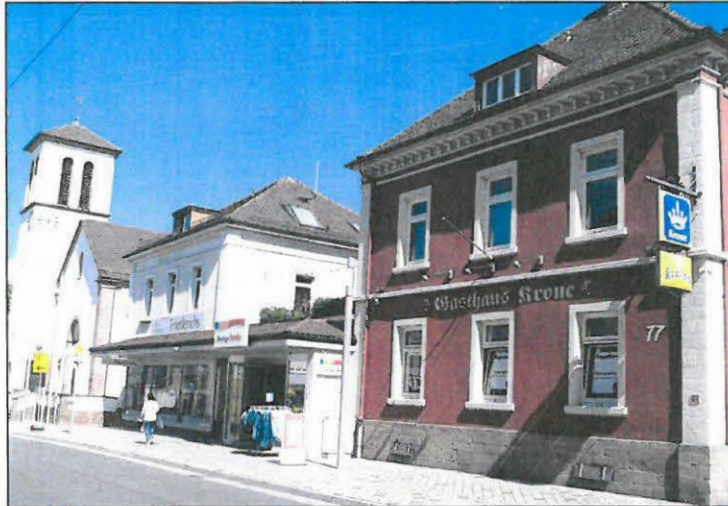
Foto: Gebäude Hauptstr. 77, Ansicht Hauptstraße, 2018
