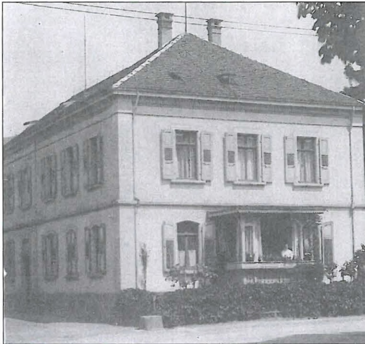
Foto: Gebäude Hauptstr. 79, Ansicht Hauptstraße / Ecke Kapuzinergasse
