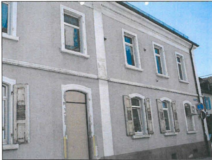
Foto: Gebäude Hauptstr. 79, Ansicht Kapuzinergasse, 2018
