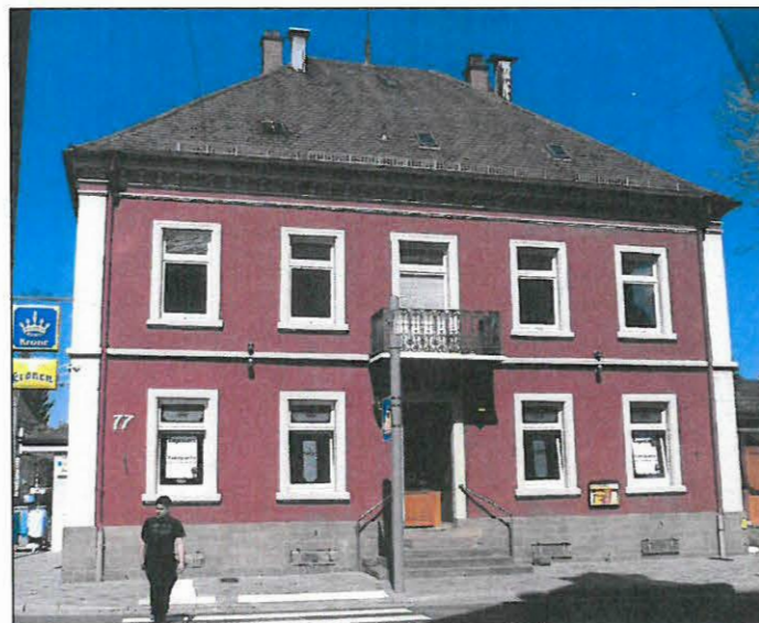
Foto: Gebäude Hauptstr. 77, Ansicht Renchener Straße, 2018
